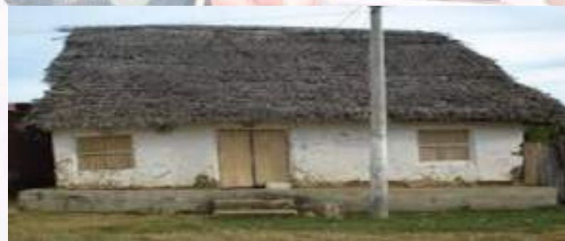
Construcciones en bahareque
