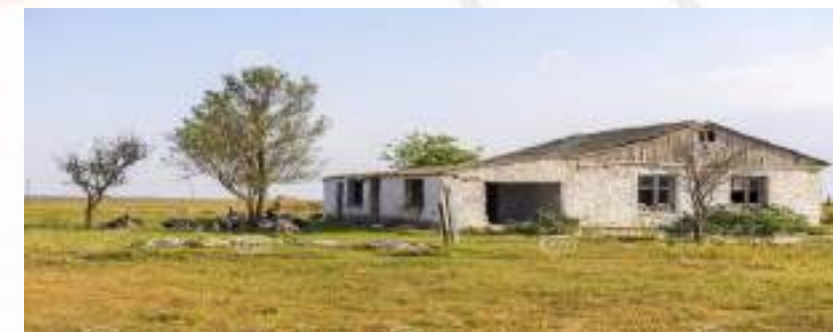
Casas en despoblado o en mal estado
